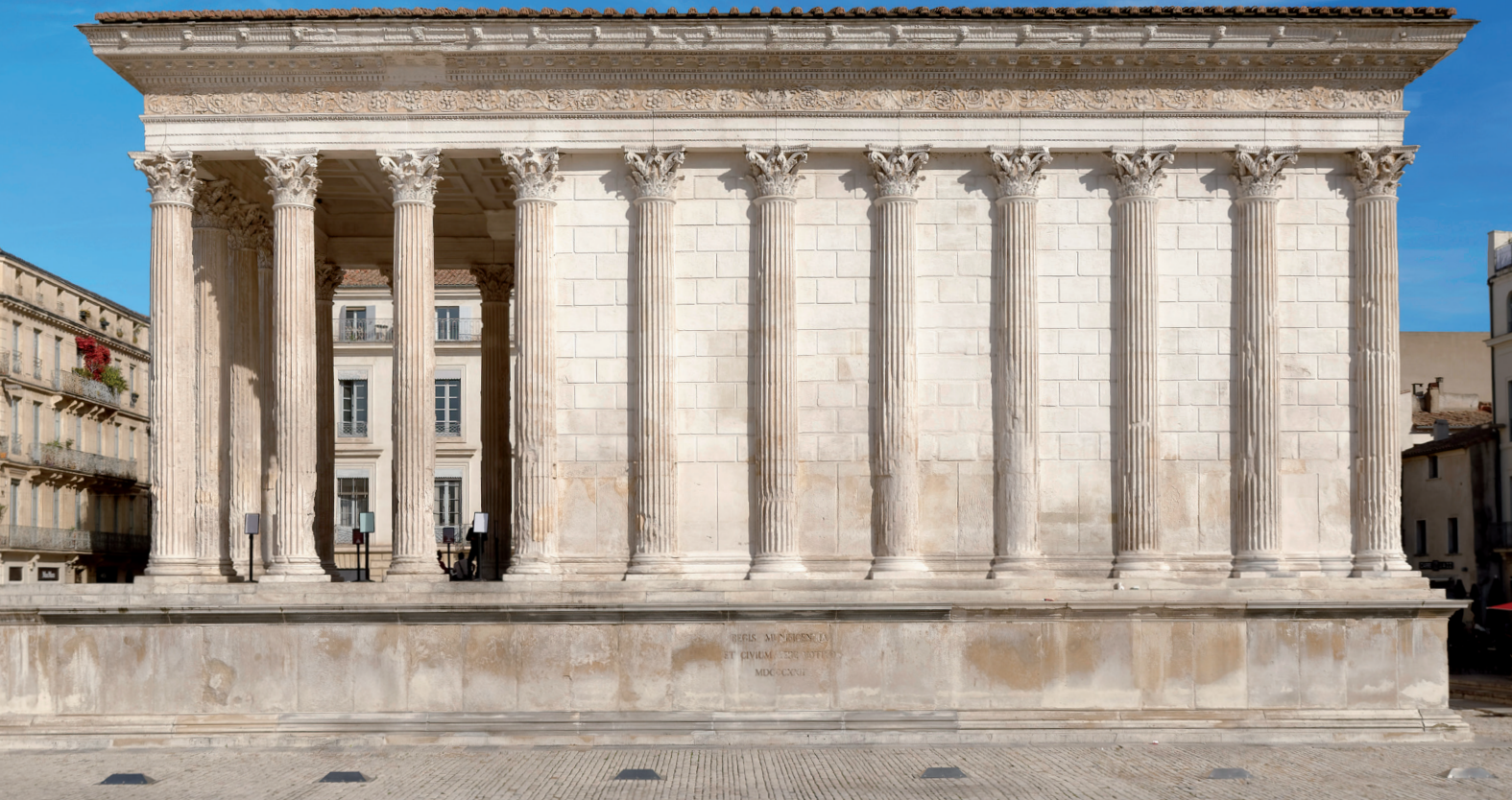
Vue de la façade ouest View of the west facade
