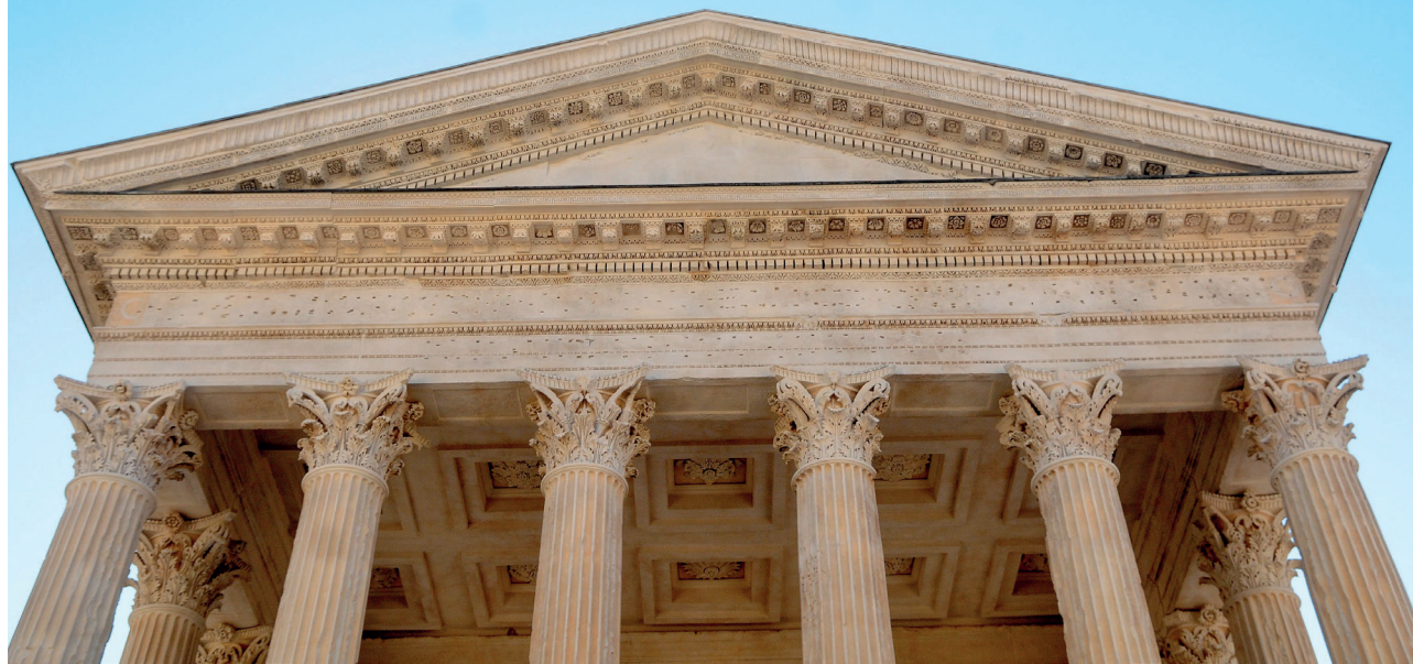
Détail de la façade nord avec les trous de scellement de la dédicace sur la frise et l'architrave Detail of the north facade with the fixing holes for the dedication on the frieze and architrave
