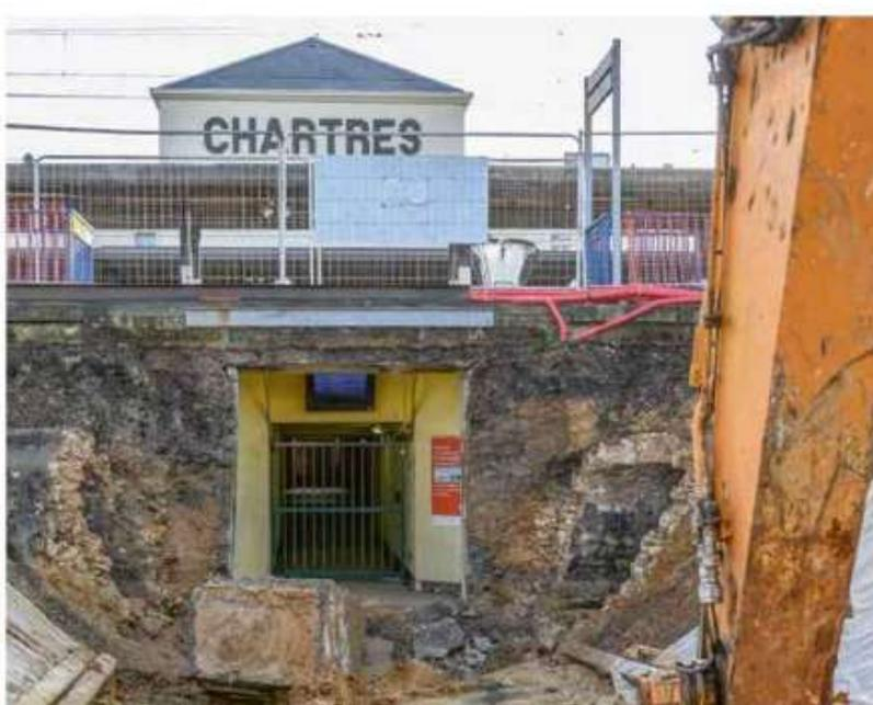
**L'**aiguille du chrono trotte. Le 2 novembre a démarré le percement du tronçon de tunnel qui établira la connexion entre le niveau -2 du futur parking Q-PARK du Pôle Gare, et le souterrain d'accès aux quais. Un chantier chronométré puisque, comme le met en évidence Nicolas Ducrot, responsable travaux du chantier Q-PARK, « quand une intervention qui concerne le périmètre de voies ferrées nécessite une
