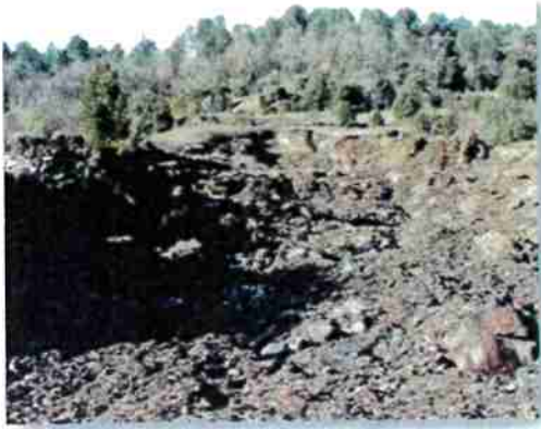
Glissement des Ribas, sept. 2002 © BRGM
