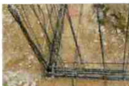
Noeud de chaînage - Continuité mécanique
