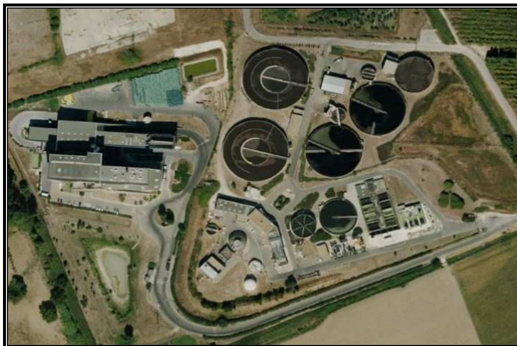
Photographie aérienne de la Station de traitement des eaux usées de Nîmes – Siradel 2013.
