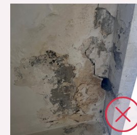
Dégradations importantes causées par le système d'évacuation des eaux pluviales
