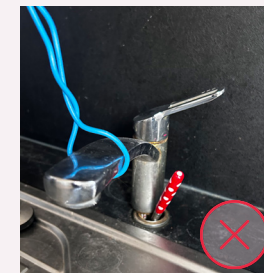
Installation instable du robinet de l'évier
