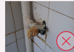
Robinet de gaz non sécurisé avec risque d'intoxication
