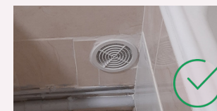
Grille basse conforme et entretenue
