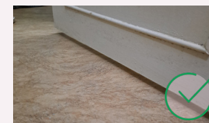
Porte détalonnée (raboter les portes de 1cm du sol et 2cm pour la porte de la cuisine)
